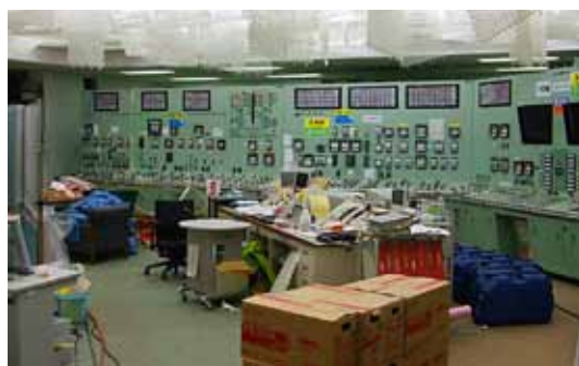
▲ 福島一場1號機控制室在強震與海嘯侵襲後，一片狼籍。
