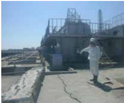
▲福島一廠2號機附近，裂開的水泥窖
