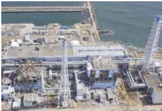
▲ 福島核一廠3、4號機廠房外觀
